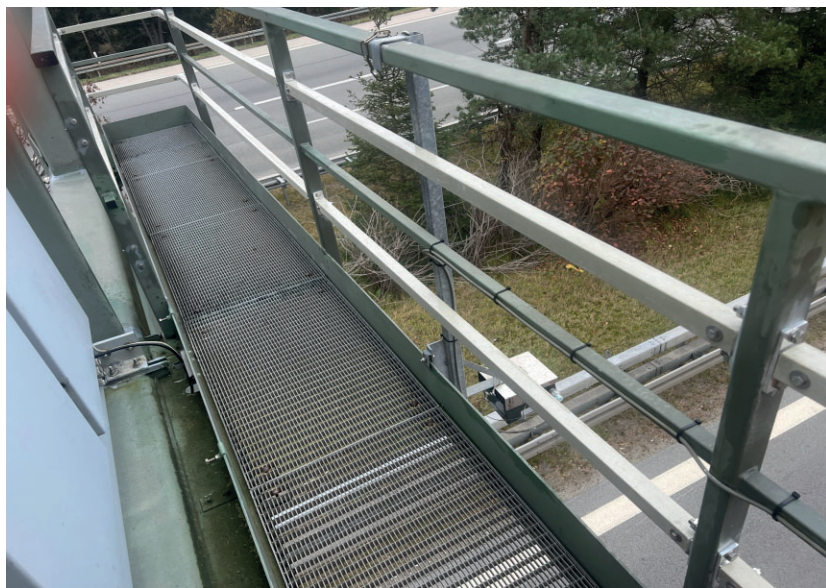
Auf dem Wartungssteg wurden Zwischenholme im bestehenden Geländer nachgerüstet, so dass die heute geltenden Richtlinien eingehalten werden.
