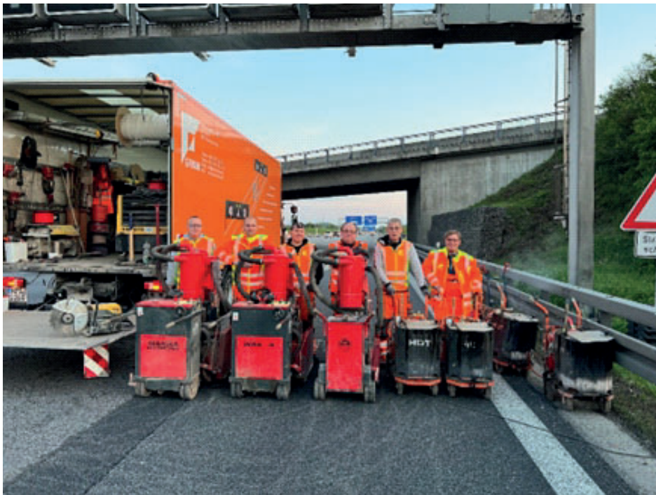
Bei der großflächigen Asphalterneuerung auf der BAB A 9 bei München waren beide Teams gemeinsam im Schichtbetrieb tätig und trugen zum Gelingen der Gesamtmaßnahme entscheidend bei.
